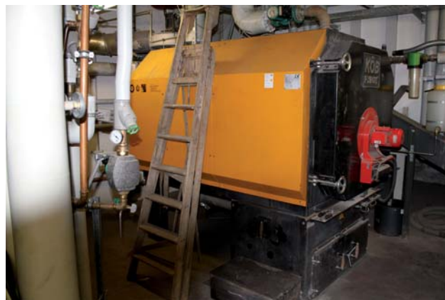
Abb. Heizwerk in Otterfing
