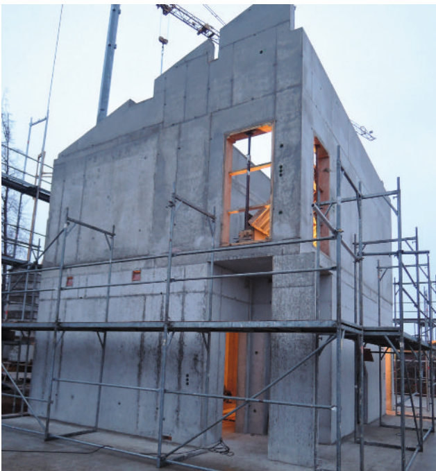
Foto: Betonarbeiten am Treppenhaus im Januar 2016
