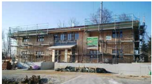
Die PV-Anlage auf dem Dach ist installiert und soll weitgehend den Eigenverbrauch an Strom decken. Eingebaut ist auch die automatische Be- und Entlüftungsanlage. Momentan muss der Estrich trocknen, danach wird mit dem Innausbau begonnen. Bodenleger, Elektriker und Sanitärfirma warten schon auf den Startschuss.
